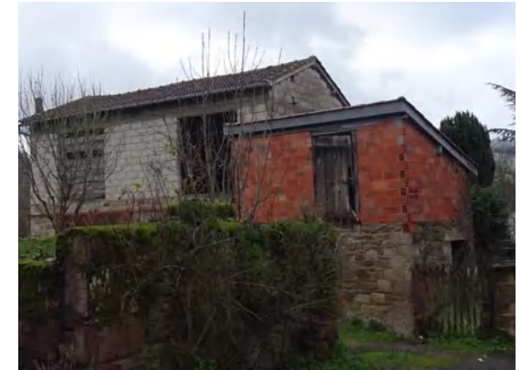
CONSTRUCTIONS EN BRIQUE ET PARPAING (AUZITS)
